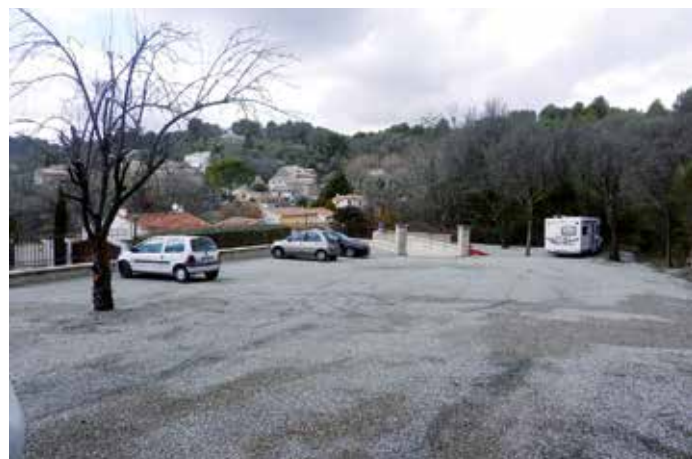
Réfection du parking des Figons
