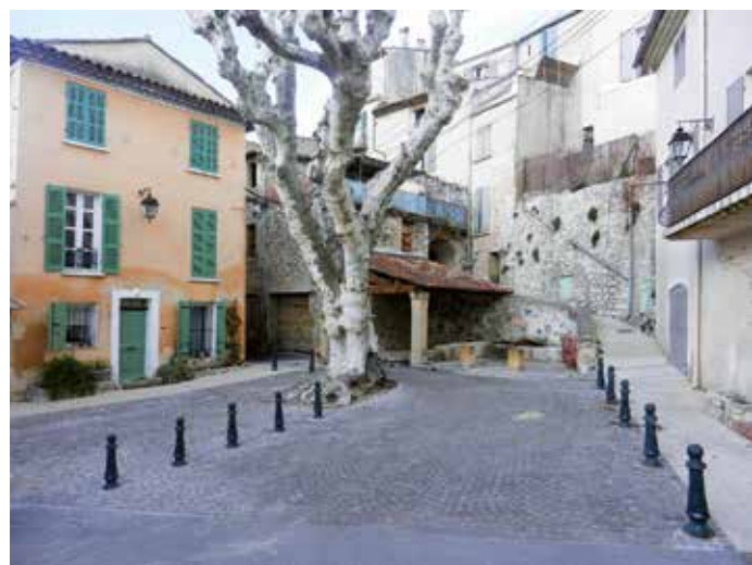
Requalification de la voirie sur la place Fontvieille, rue du Barri et rue de la Glacière
