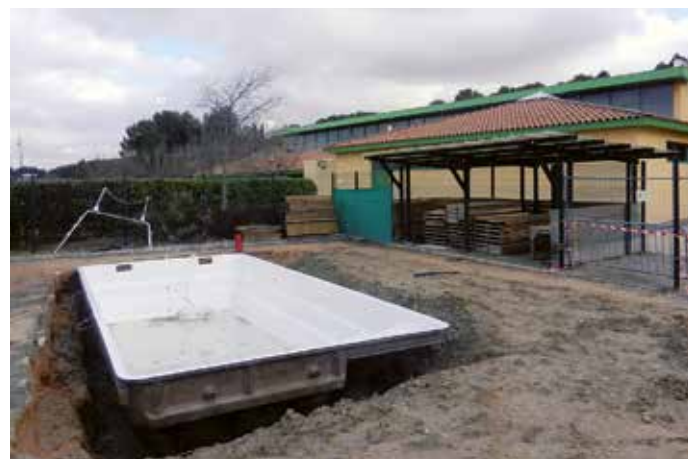
Transformation de la piscine du complexe omnisports en dur
