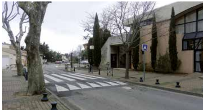
Aménagement d'un plateau traversant avenue Paul-Magallon
