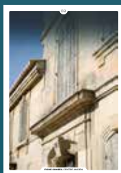
03 les façades en pierre de taille
