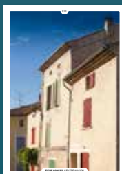
01 les façades enduites
