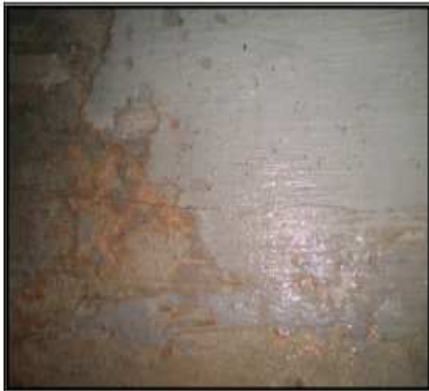
Réservoir n°2, Les Logissons de 450 m 3 , nouvelles fissures identifiées lors du nettoyage en mars 2011.
