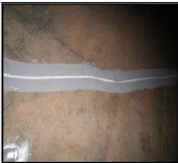
Réservoir n°2, Les Logissons de 450 m 3 , réparation des fissures.
