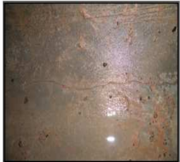
Réservoir n°2, Les Logissons de 450 m 3 , nouvelles fissures identifiées lors du nettoyage en mars 2011.
