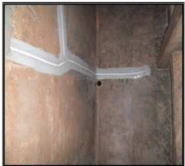
Réservoir n°2, Les Logissons de 450 m 3 , réparation des fissures.
